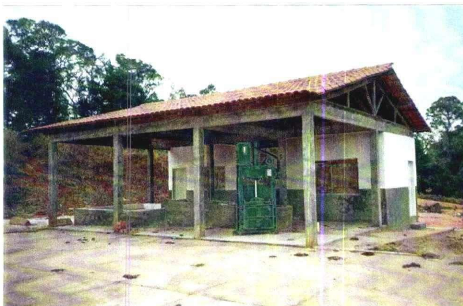
Foto 32 - Usina de separação e beneficiamento do lixo recém-construída. Balcões de separação de materiais utilizáveis, prensa e pátio para compostagem em leiras
