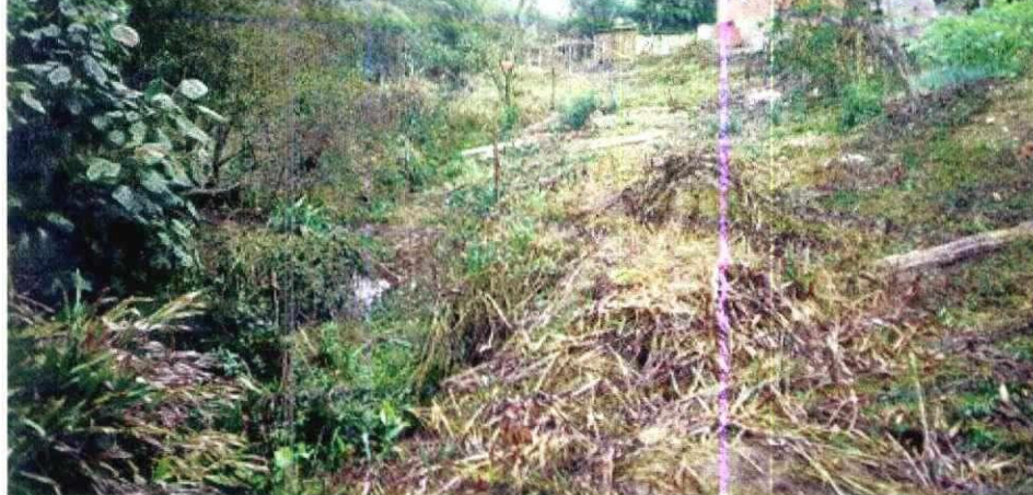
Foto 25 - Lançamentos de esgoto em curso d'água na periferia urbana. Nesses locais se propõe a construção de interceptores de esgotos de pequeno diâmetro
