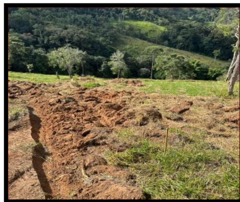
Trabalhos de terraplanagem continuam
